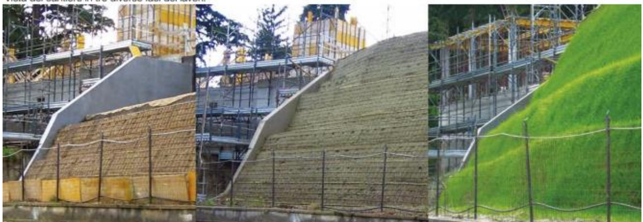
Figura 2. Fasi di esecuzione terre rinforzate
