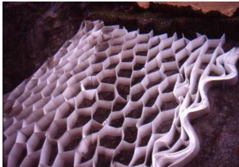
Figura 4: stesura geocelle a nido d'ape- Foto G. Sauli
