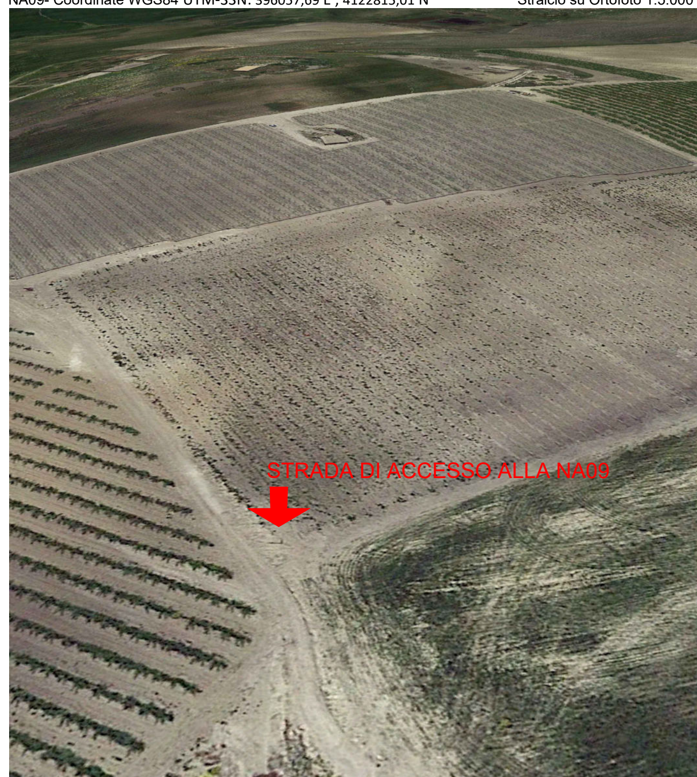
F9 - Strada di nuova realizzazione per accesso alla piazzola NA09
