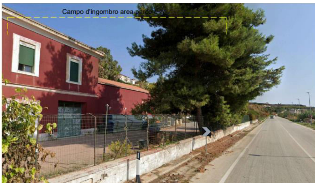
Figura 74: Ante e Post Operam - Vista dal Complesso Immobiliare Ex Stazione di Margonia (Comune di Naro)
