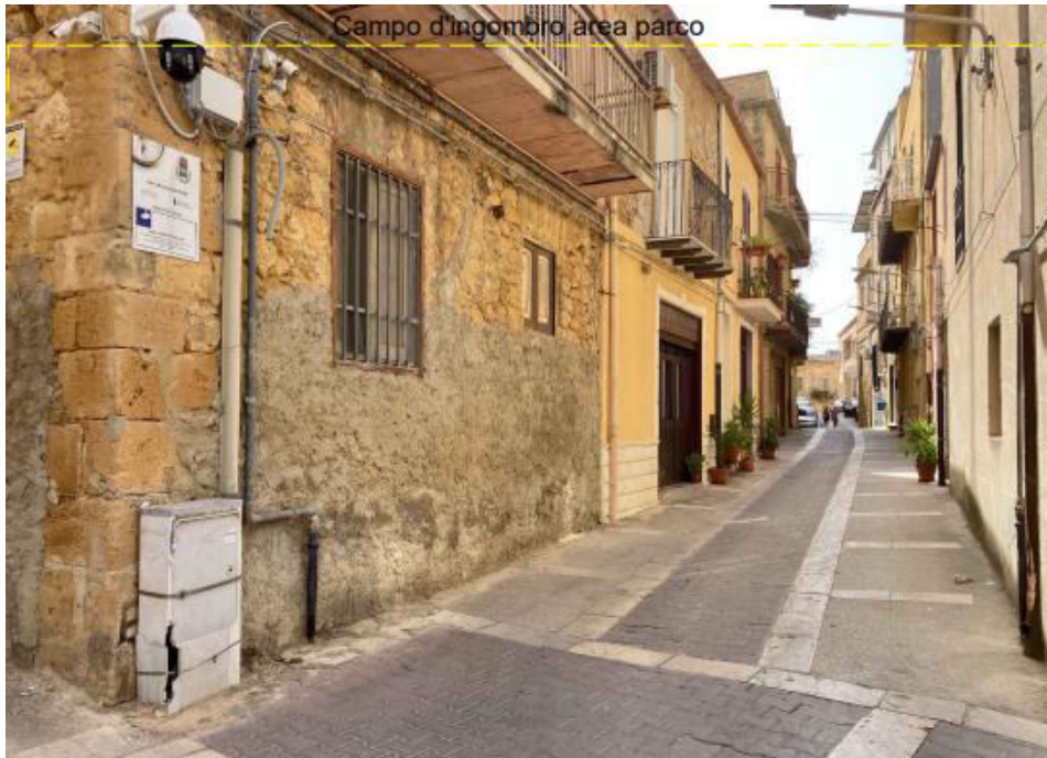
Figura 83: Ante e Post Operam - Vista dal Palazzo Bonanno (Comune di Naro)
