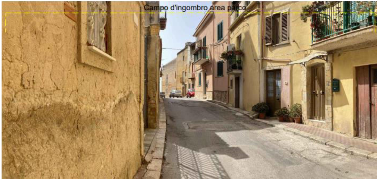
Figura 86: Ante e Post Operam - Vista dal Palazzo Lauria (Comune di Naro)
