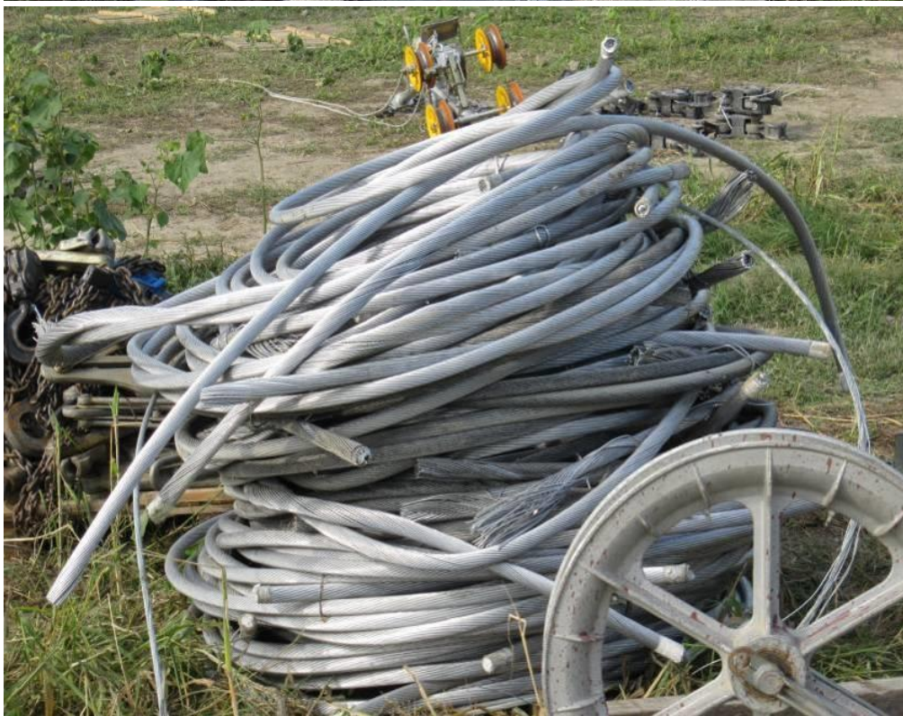
Figura 02 - Fasi demolizione di un sostegno a traliccio, particolare di materiale raccolto
