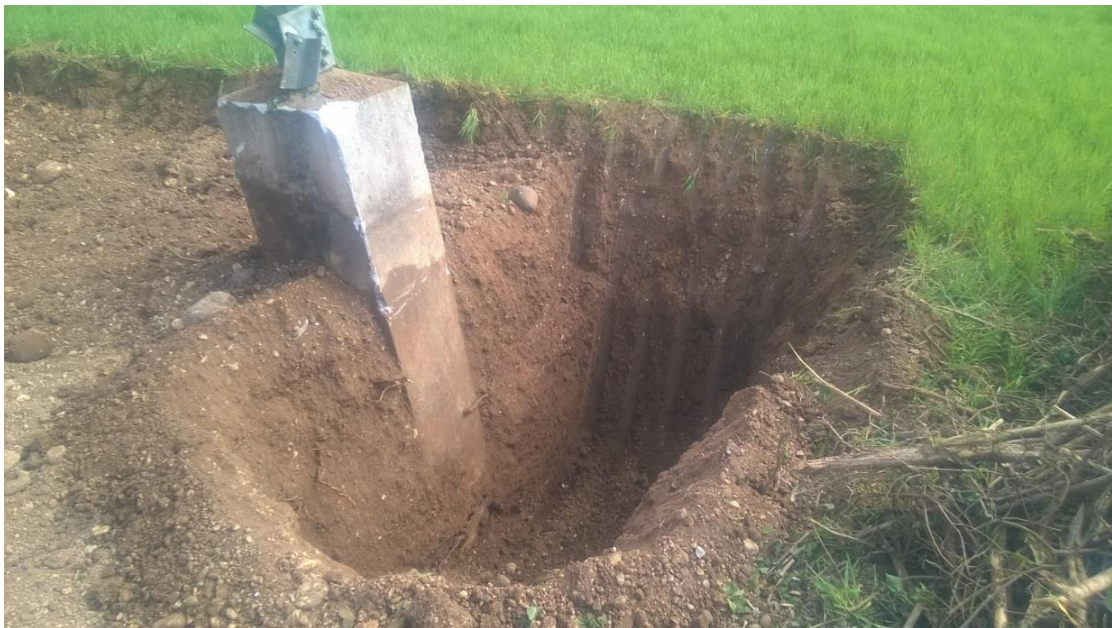
Figura 04 - Esempio rimozione della fondazione superficiale di un sostegno 380 kV ST
