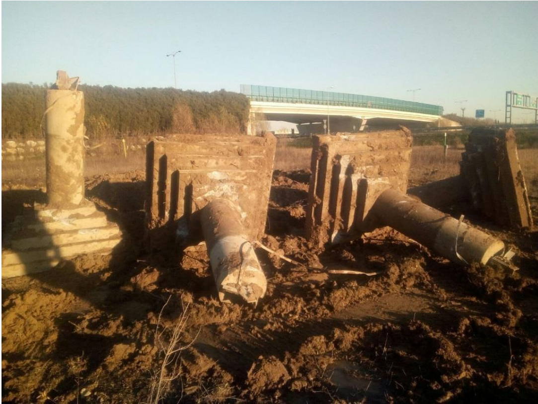
Figura 03- Esempio di rimozione della fondazione superficiale di un sostegno 220 kV
