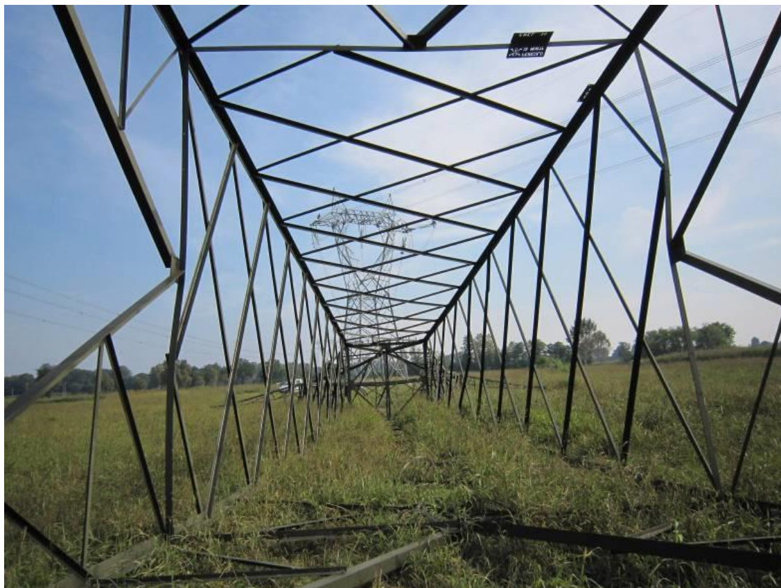
Figura 01 - Fasi demolizione di un sostegno a traliccio
