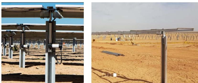
**Figura 6 - Particolare strutture ad inseguimento ed attuatore**
