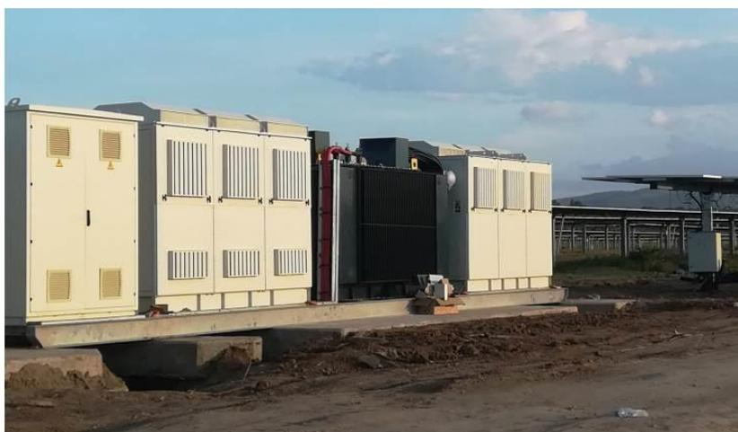
*Figura 16 - Esempio skid conversione.*
