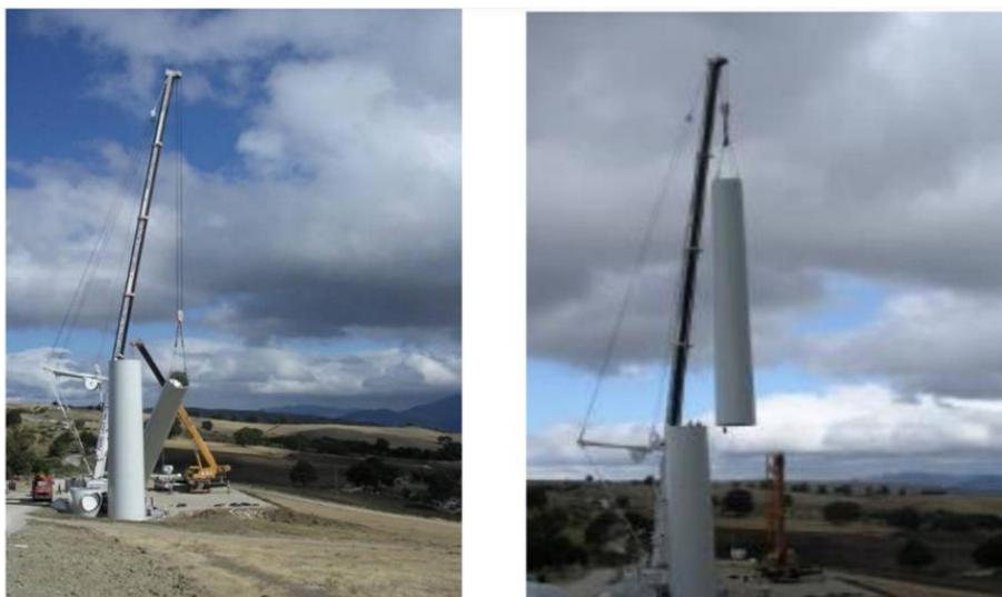
*Figura 28 – Fasi di montaggio della torre dell'aerogeneratore.*
