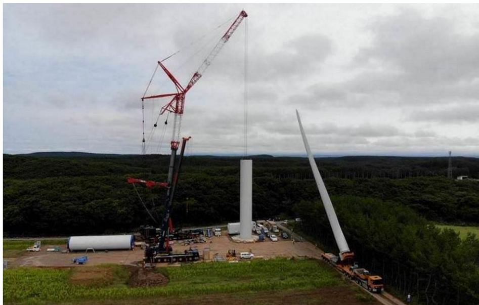
*Figura 14 – Fasi di montaggio della gru principale e della torre dell'aerogeneratore.*
