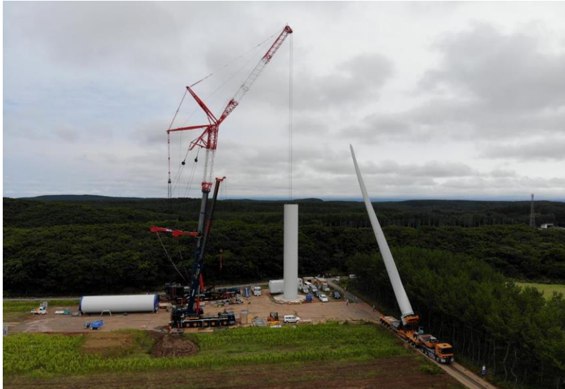
Figura 3 – Montaggio dell'aerogeneratore con gru principale.
