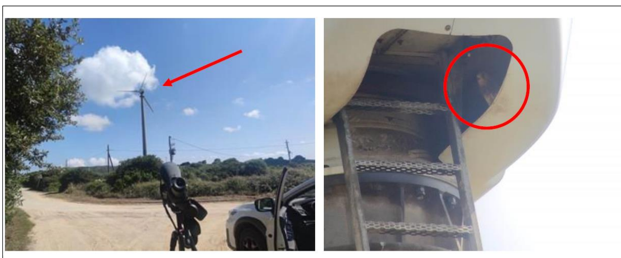
Figura 6 Nido di gheppio ( Falco tinnunculus ) localizzato all'interno della struttura della turbina eolica, come si può vedere dalla freccia nell'immagine a sinistra. A destra si può notare l'individuo presso il nido.
