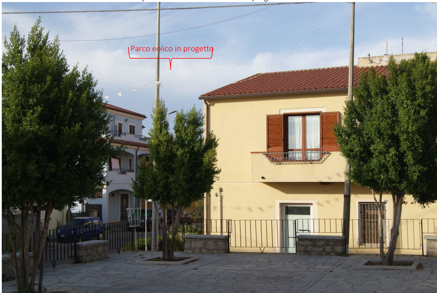
PS48 - Via S. Mara - Bassacutena-Tempio Pausania- Stato di fatto e di progetto
