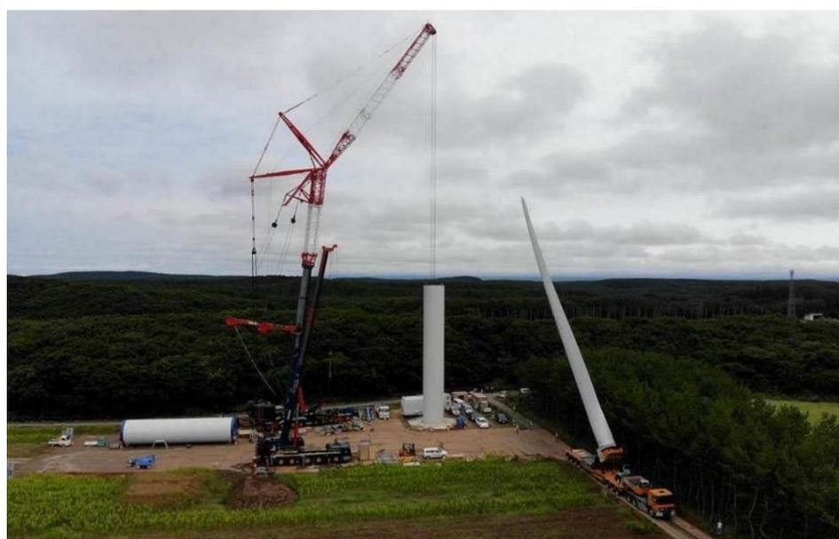
*Figura 15 – Fasi di montaggio della gru principale e della torre dell’aerogeneratore.*
