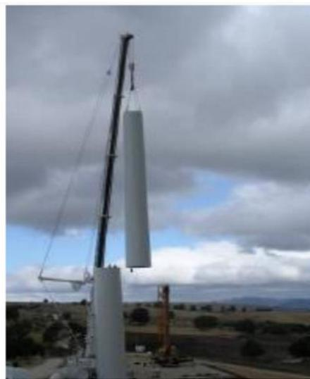
*Figura 27 – Fasi di montaggio della torre dell'aerogeneratore.*
