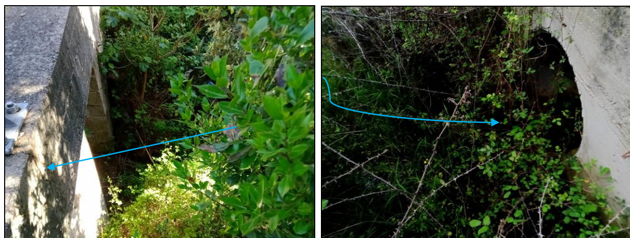
Figura 9 – Manufatto relativo all’interferenza C.3 (SX) e attraversamento per le interferenze C.4 – C.5 e C.6.
