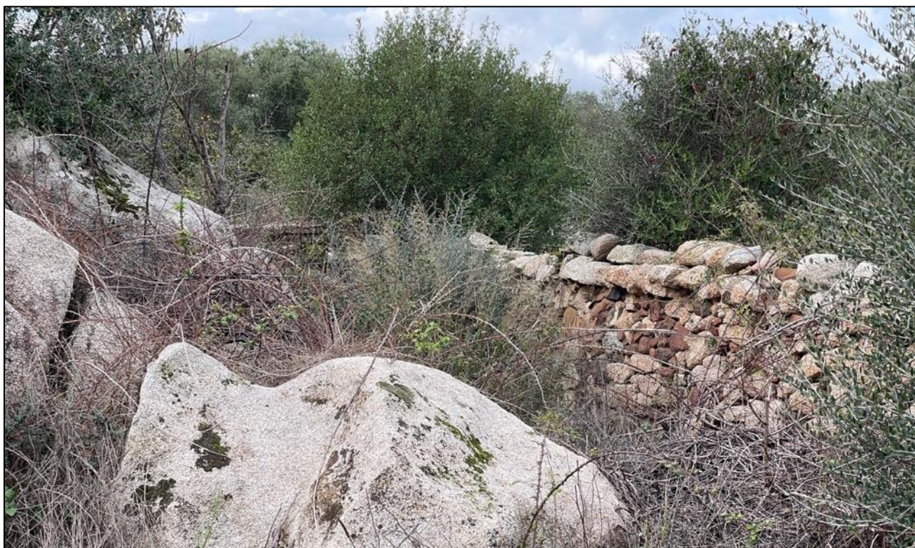
FIGURA 8 – Esempio di muro a secco con blocco lapideo di roccia effusiva in oliveto
