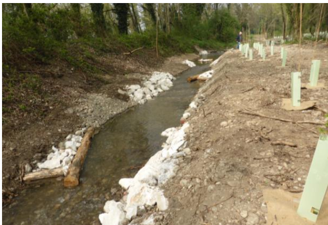
Figura 3. Intervento di diversificazione dell'alveo di un canale di connessione tra il fiume Oglio e una lanca laterale (Parco Regionale dell'Oglio nord, Comune di Pumenengo, Provincia di Bergamo)
