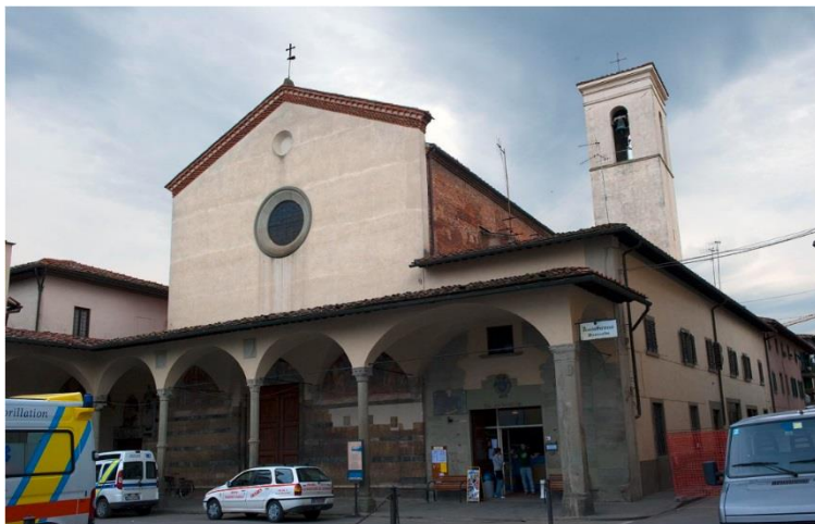
Figura 4.4.5 - Convento e chiesa di San Francesco – facciata
