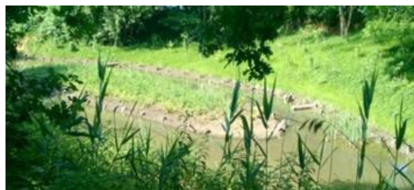
Figura 2.3.53: Intervento di riqualificazione intra- alveo (Roggia Vernavola, Pavia)
