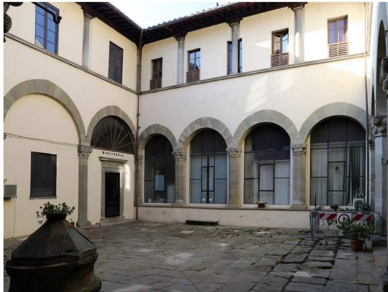
Figura 4.4.14 - Villa di San Cerbone – cortile interno
