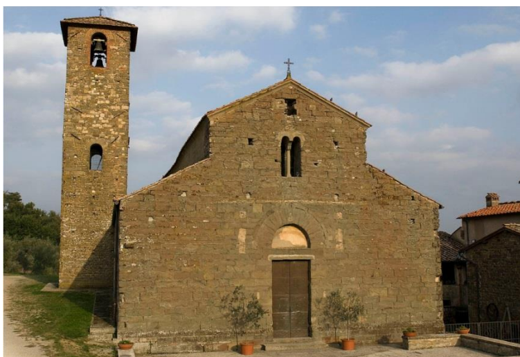
Figura 4.4.8 - Pieve di San Romolo - facciata
