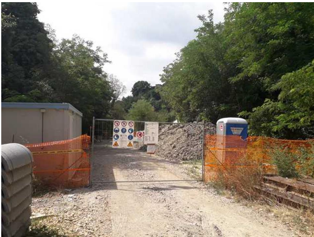
Figura 2.4.5 – Dotazioni minime aree cantiere individuale
