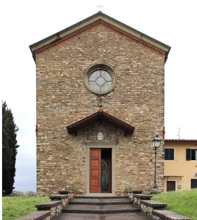
Figura 4.4.10 - Chiesa di Santa Maria di Loreto – facciata
