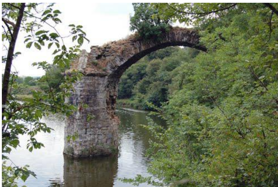
Figura 4.2.5 – Ponte del Romito sull'Arno
