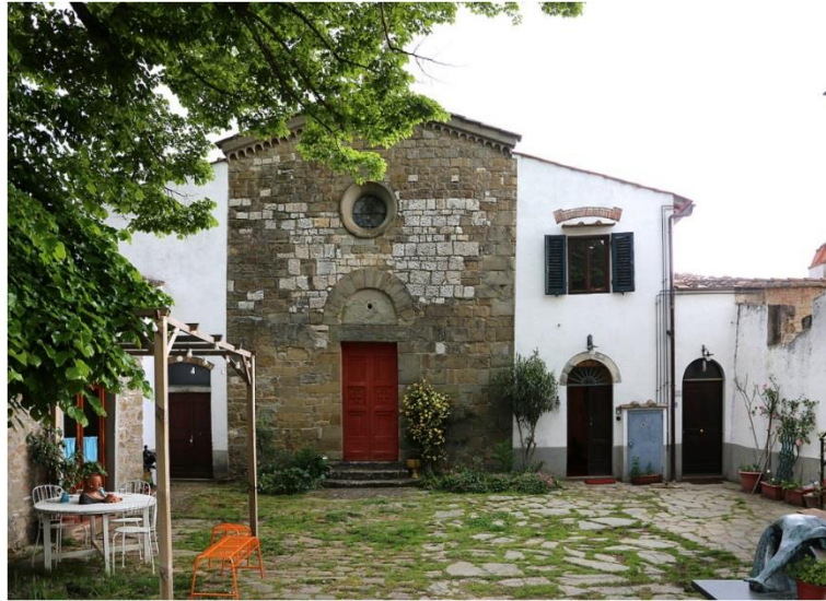
Figura 4.4.11 - Chiesa di San Michele -facciata
