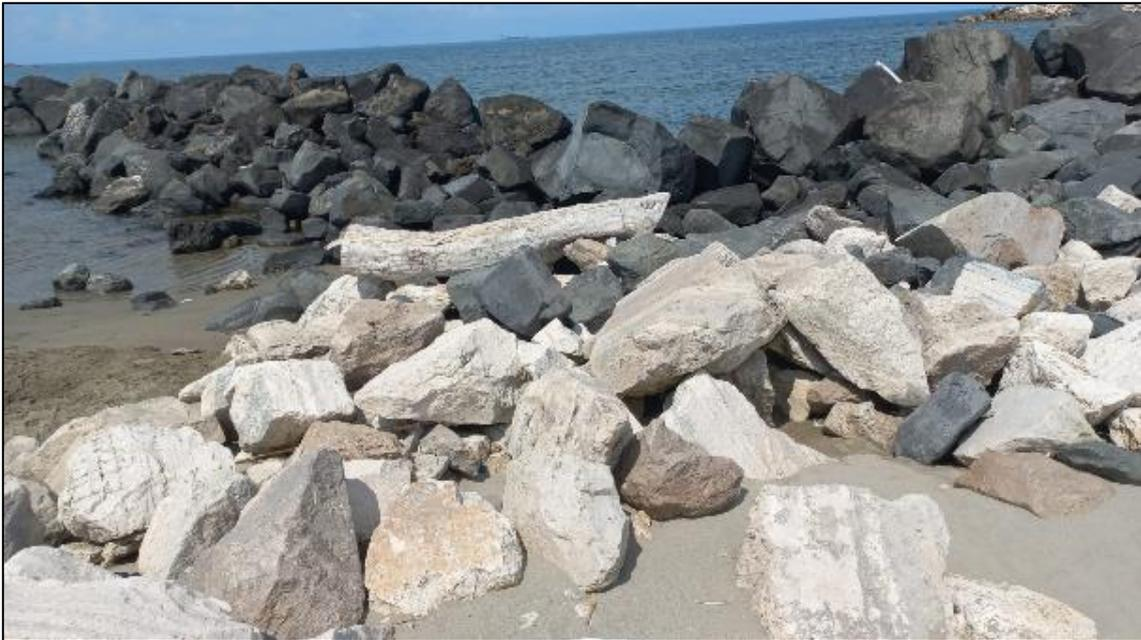
Figura 4.9: Depositi antropici. Blocchi costituenti le barriere di protezione antierosione
