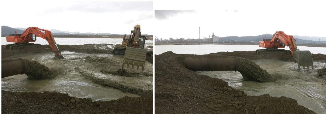
Figura 5.13: Gestione del materiale di dragaggio nelle aree con riempimento in acqua
