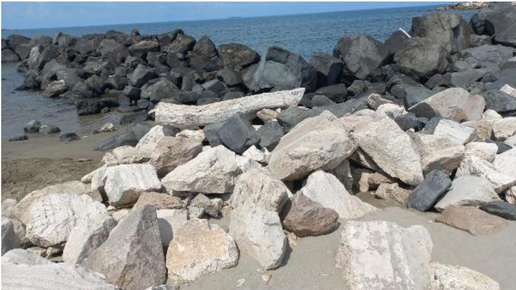
Figura 4.13: Blocchi costituenti le barriere di protezione antierosione
