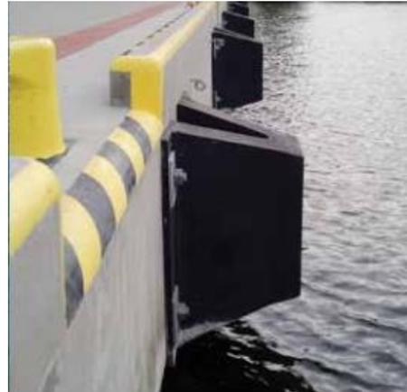
Figura 2-1: Parabordi tipo Arch Fenders
