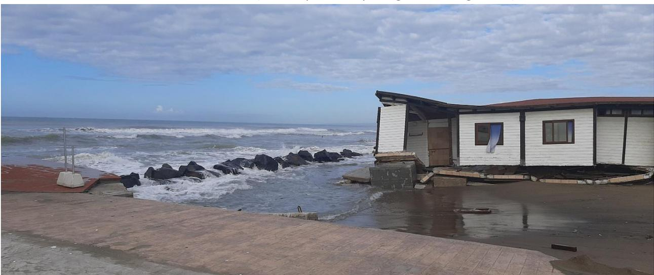
**Figura 20 - Crollo delle cabine de La Nave a seguito delle mareggiate dell'inverno 2022; foto n. 1.**
