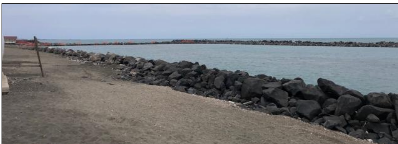
Figura 7 - Cantiere di realizzazione di barriere emerse longitudinali e trasversali nel tratto a sud del litorale di Fregene.
