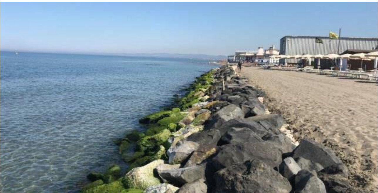
Figura 7 - Opera di difesa aderente realizzata in urgenza nel 2020
