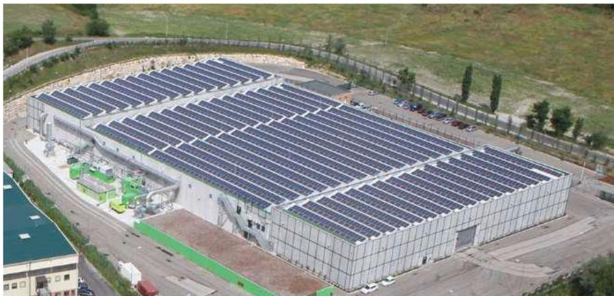
**Figura 4.27: La soluzione mitigativa proposta per eliminare l'effetto attrattivo esercitato dall'ampia superficie piana dei tetti degli edifici previsti dal Piano, prevede l'utilizzo di pannelli fotovoltaici. L'immagine raffigura un capannone di un impianto in Emilia-Romagna.**
