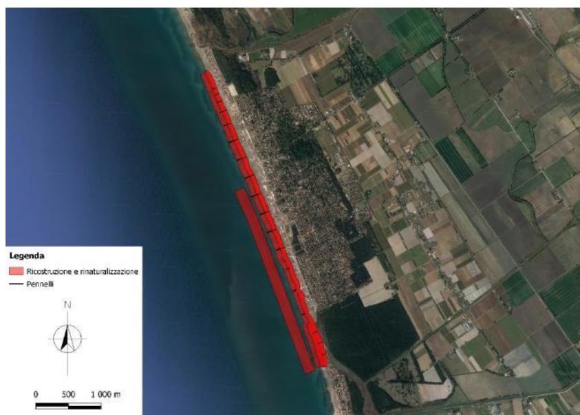
Figura 3.3: Tratto costiero oggetto di ricostruzione degli arenili di Fregene e rinaturalizzazione della riserva di Macchiagrande
