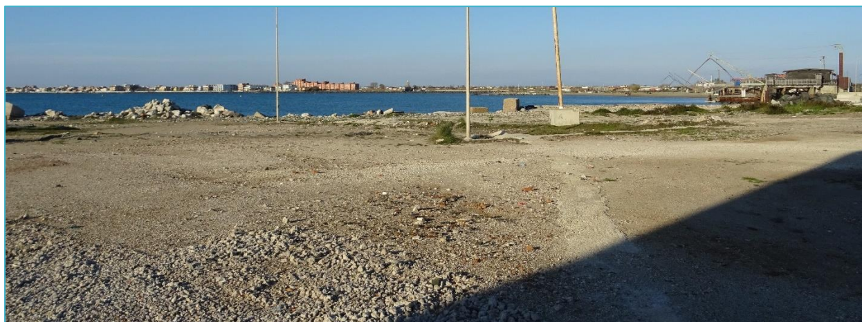
Figura 6.12: Vista del bacino portuale dalla zona del faro verso est-nord-est. Bilancioni, costruzioni fatiscanti e cantiere del porto abbandonato.
