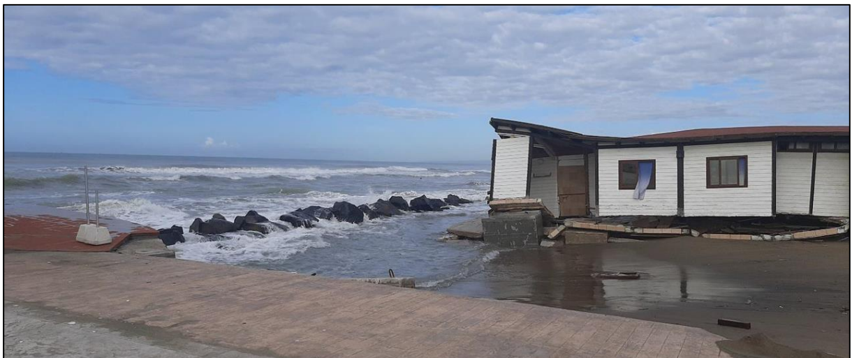
Figura 8.2: Crollo delle cabine de La Nave a seguito delle mareggiate dell'inverno 2022; foto n. 1
