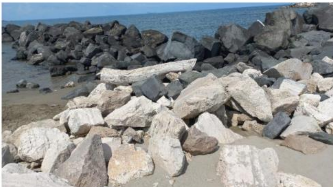
Figura 4.9: Blocchi costituenti le barriere di protezione antierosione
