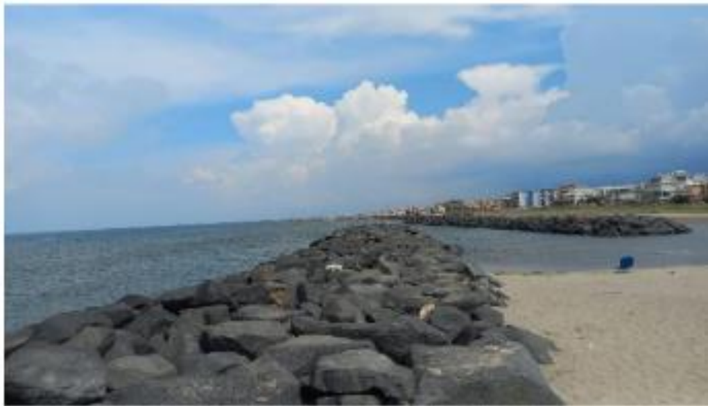
Figura 4.7: Panoramica delle barriere antierosione
