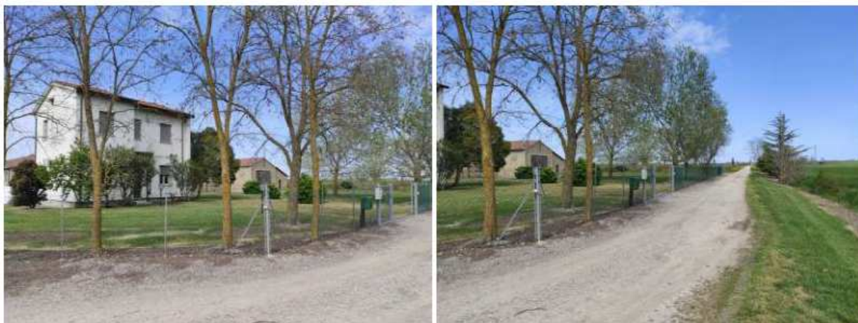
Ric2 - Abitazione e viabilità di accesso
