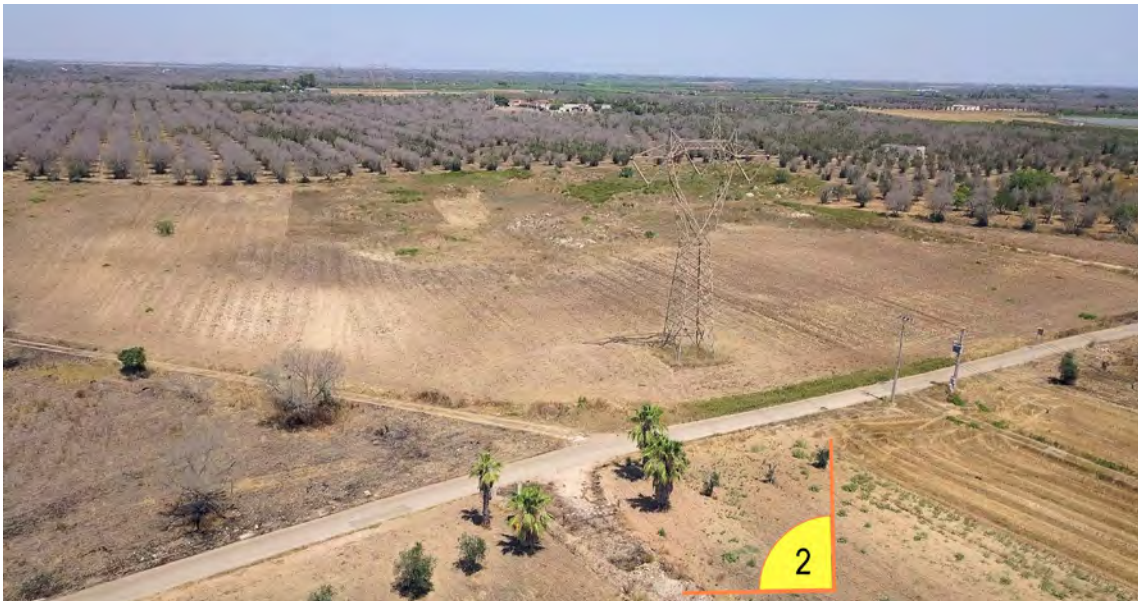
Fig. 25 - Report fotografico - Ingresso area SE TERNA da strada pubblica comunale
