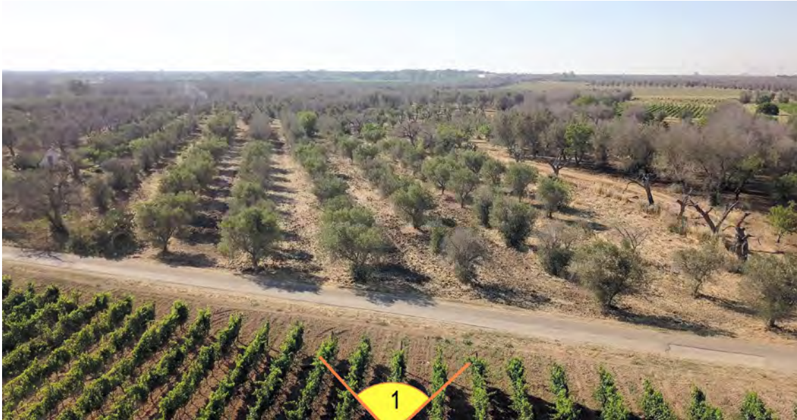
Fig. 24 - Report fotografico - Ingresso area SSE da strada pubblica comunale
