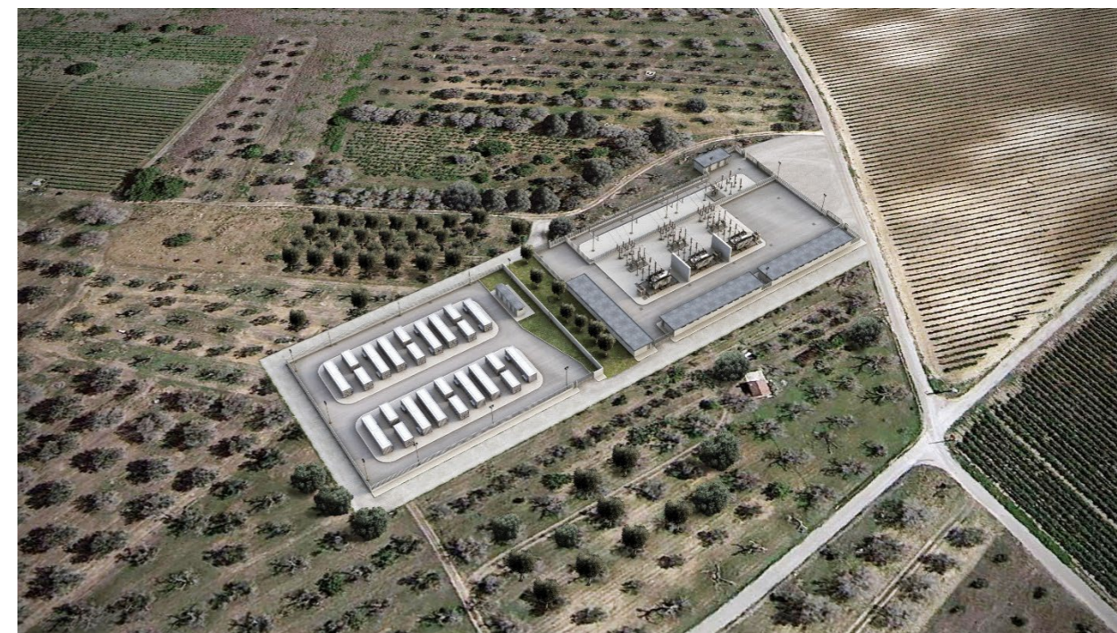
Rilievo 3D Post operam - vista d'insieme cabina utente e impianto di accumulo
