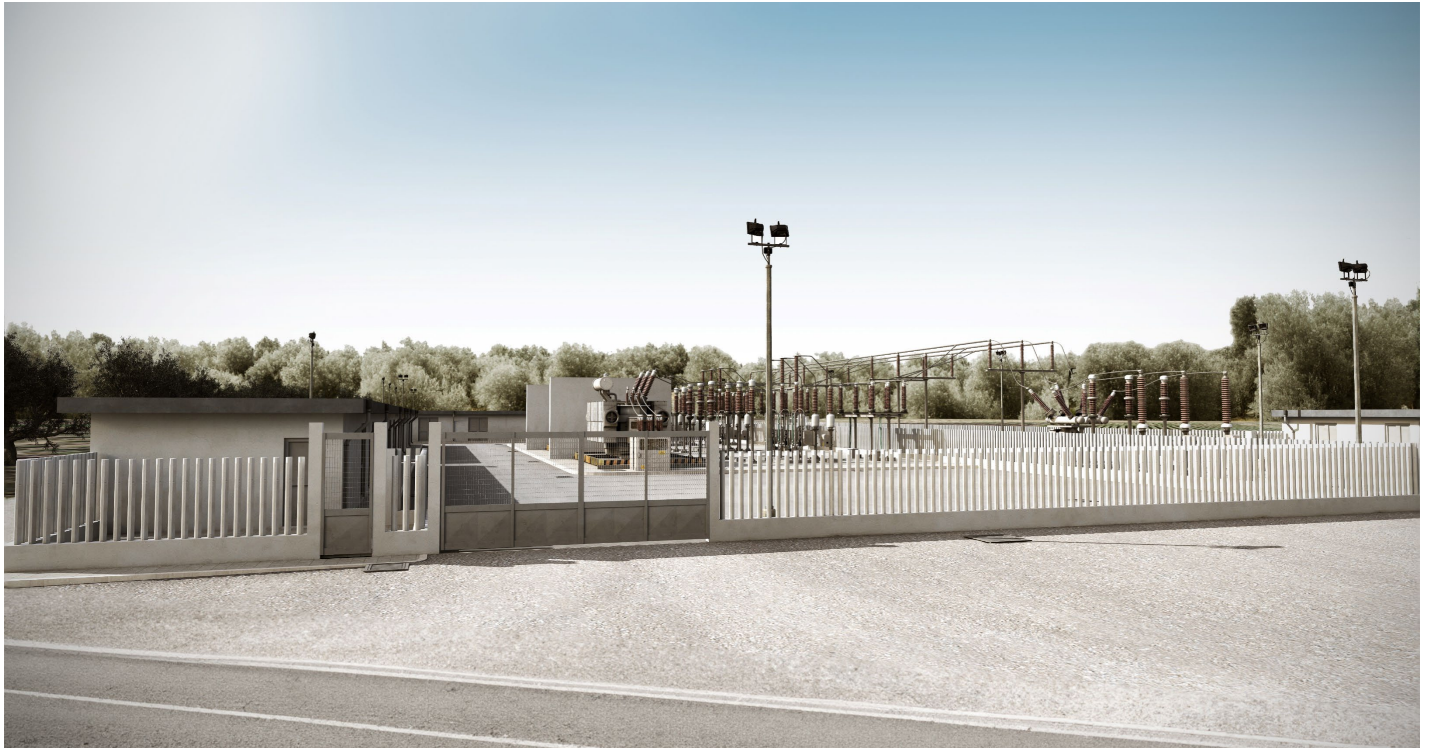
Ingresso Cannello principale CABINA UTENTE – Accesso da via pubblica.
