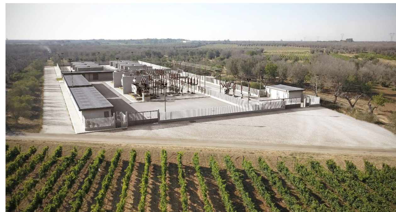
Rilievo 3D Post operam – Ingresso cabina
