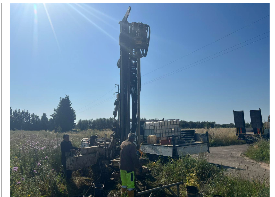
Postazione ed Esecuzione sondaggio S1 – aerogeneratore N04
