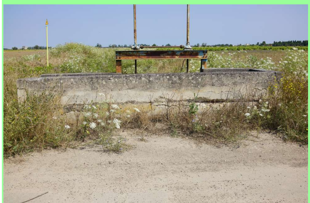
Figura 60: Canale intersecato dal tracciato del cavidotto (Punto rilievo: W115).
