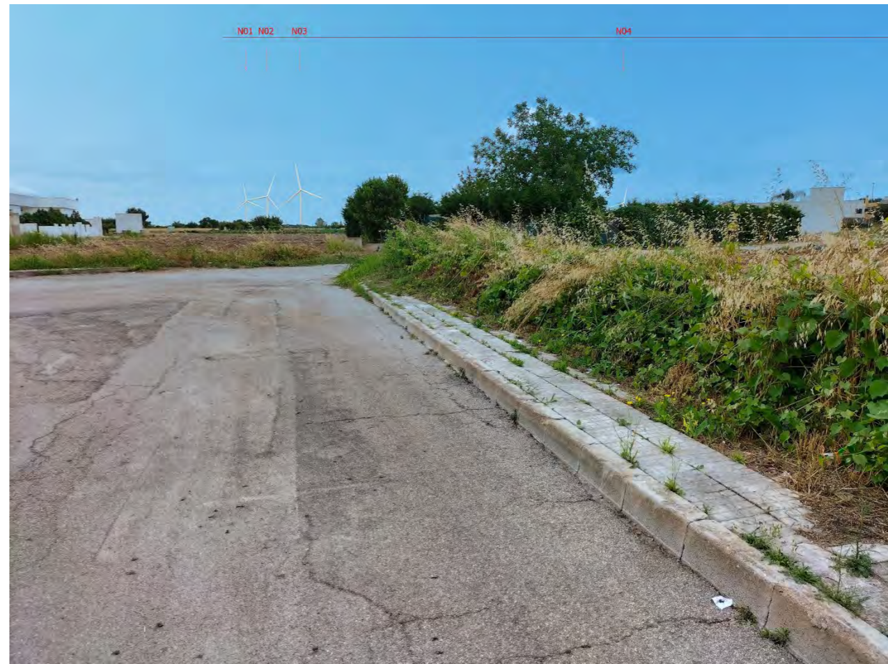
Vista A1-1 post operam cumulativo
