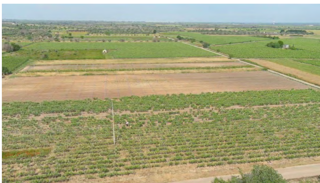
Ingresso WTG N05
