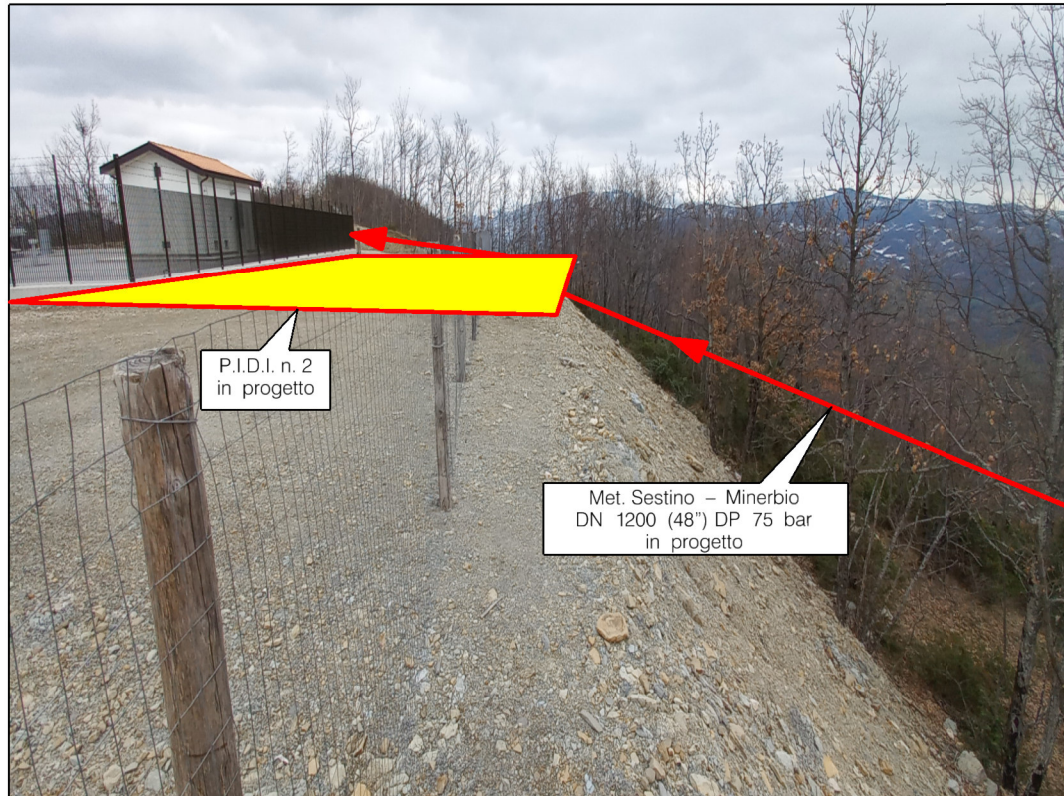
Percorrenza della condotta in prossimita' dell'impianto in progetto "PIDI n.2", in Comune di Badia Tedalda
