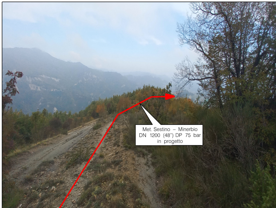
Percorrenza del tracciato in cresta in area boscata in Comune di Sestino
