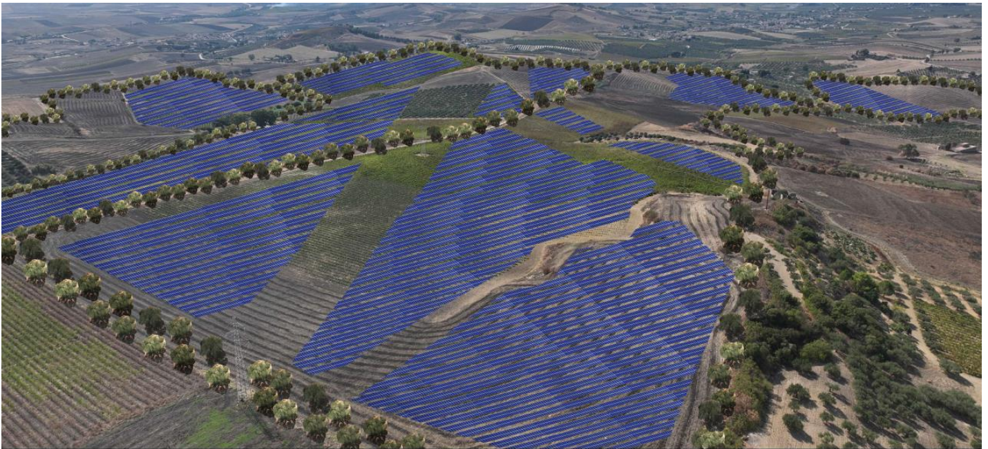
Fotoinserimento C - stato POST operam impianto "Erice 57"
