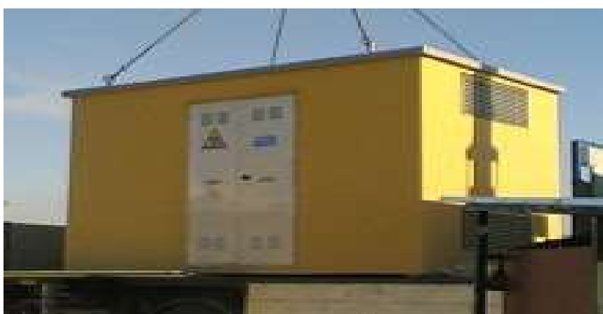
Figura 2: Tipologia cabine per quadri elettrici
