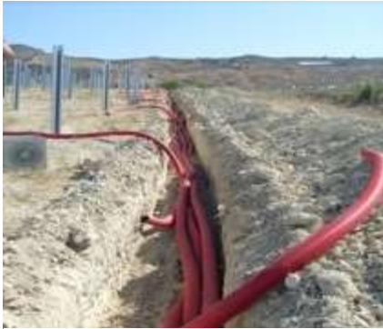
Figura 3: Tipo Cavidotto interrato
