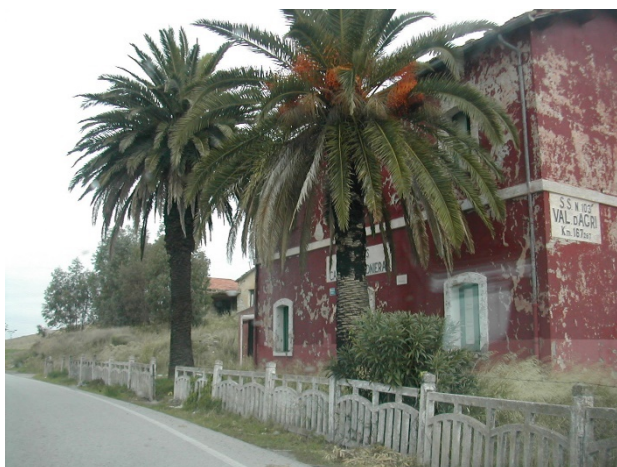
Figura 4– Casa cantoniera in prossimità del bivio di accesso al sito dalla SS. 103
