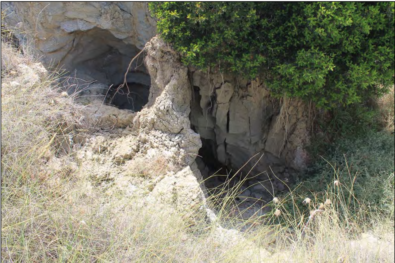
Foto 10 – Esempio di disagregazione e conseguente erosione delle argille per azione dell'acqua
