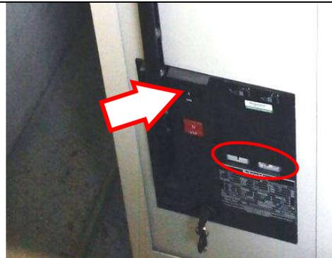
Dopo la chiusura del DG, automaticamente si deve chiudere l'interruttore DI. Se non viene eseguito dopo 30s, premere il pulsante ROSSO (I - "On") sull'interruttore del dispositivo di interfaccia DI. Se compare il "I" su sfondo bianco l'interruttore è chiuso.
