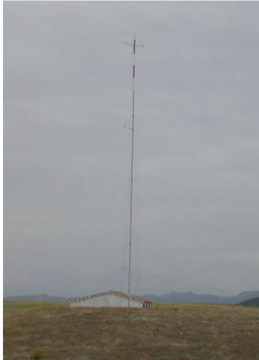
Figura 4 – Stazione anemometrica MPE 30, presso Contrada Bersagliere – Comune di Montalbano Jonico
