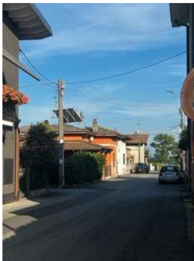
Abitazioni in Fornace Crocchio
