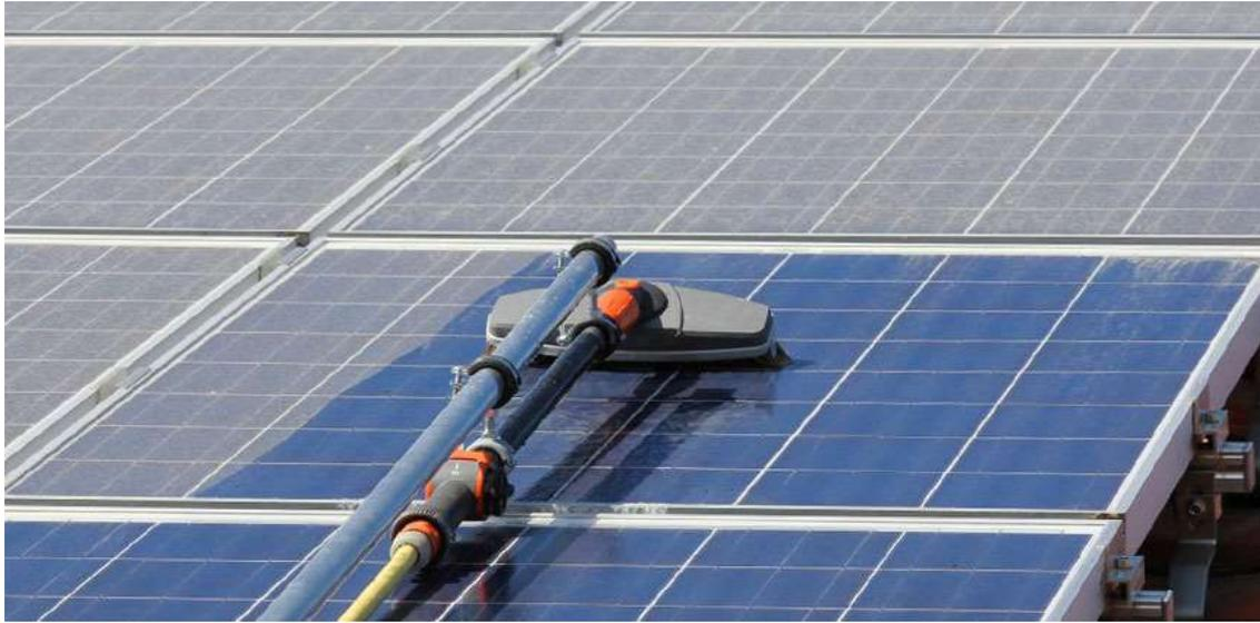
Figura 25 - Esempio pulizia pannelli fotovoltaici
