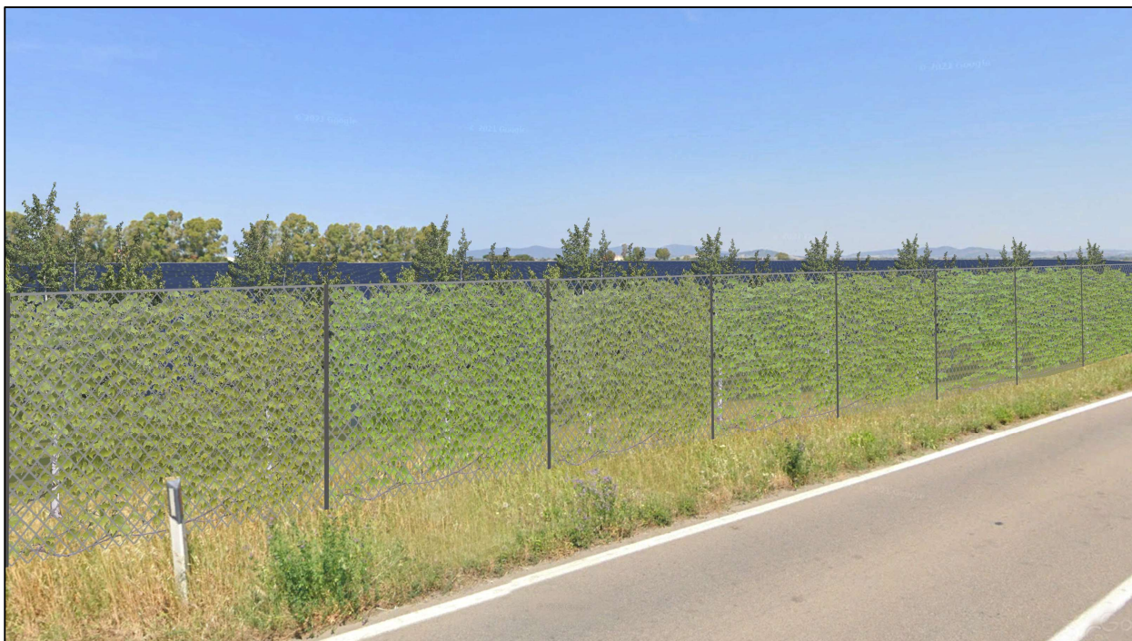
Figura 40 – Vista 3 – Post operam con mitigazione
