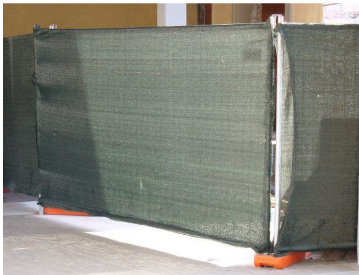
Figura 14: Immagine esemplificativa - telo antipolvere in bandella HDPE
