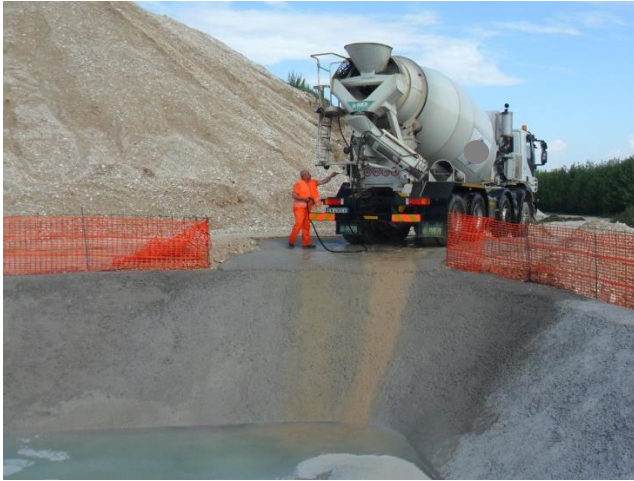
Figura 2 Esempio di lavaggio di un'autobetoniera (a sinistra) e dettaglio di una vasca di raccolta (a destra).
