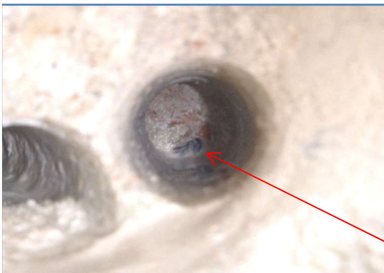
Barra di armatura a circa 32 cm dalla barra d'angolo
