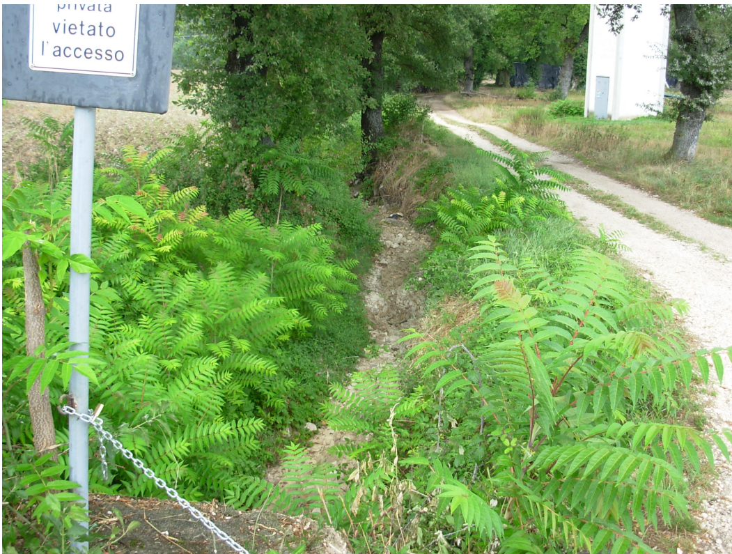
Figura 12. Fosso di S. Antonio in corrispondenza del viadotto Mulini (vista verso valle).
