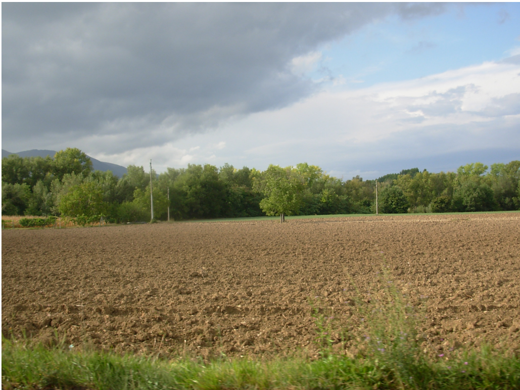
Figura 6. Destra idraulica del torrente Marroggia in corrispondenza del rilevato alla fine del viadotto Marroggia I.
