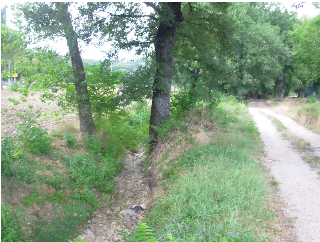
Figura 14. Fosso di S. Antonio in corrispondenza della sez.71 (vista verso valle).
