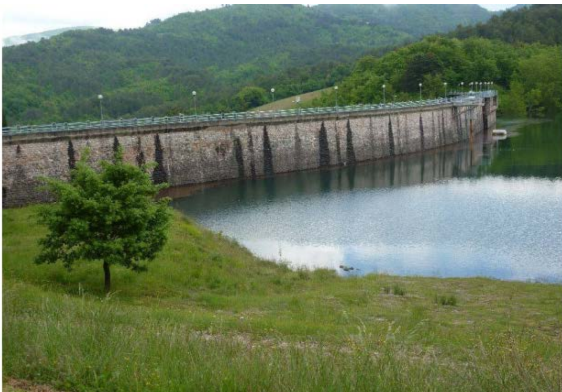
Figura 2. Vista dello sbarramento da monte (fonte Consorzio di Bonificazione Umbra)
