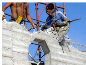
Demolizione eseguita manualmente
