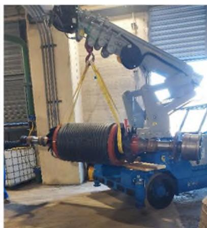
**Rimozione motore rotore di traino MG set "B"**
