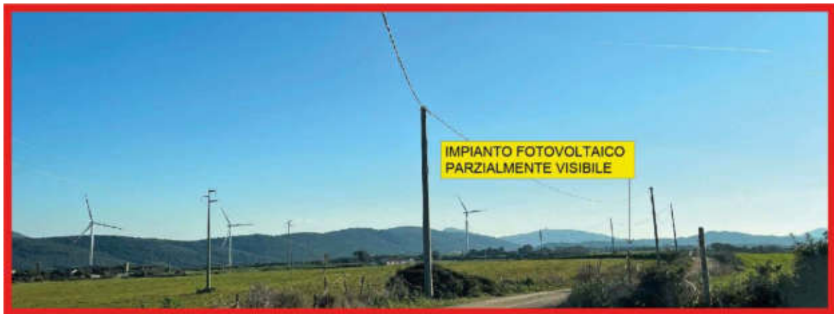
Figura 146 - Impianto eolico S.E.S. – Lotto 2
