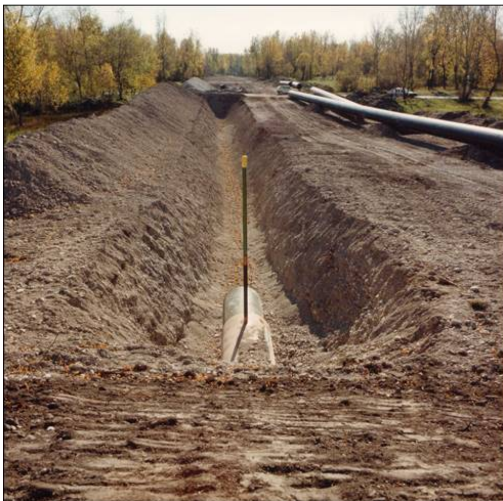
Sfiato (prima della sistemazione finale dell'area di lavoro)
