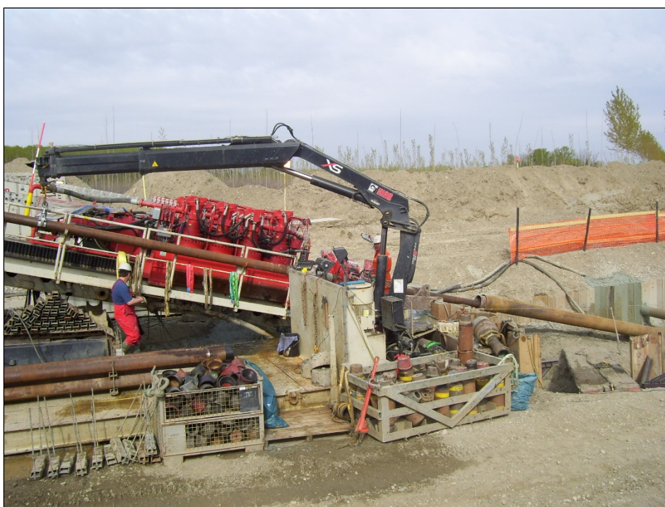
Attraversamento. F. Po con met. 30" – "Rig", durante la realizzazione del foro pilota
