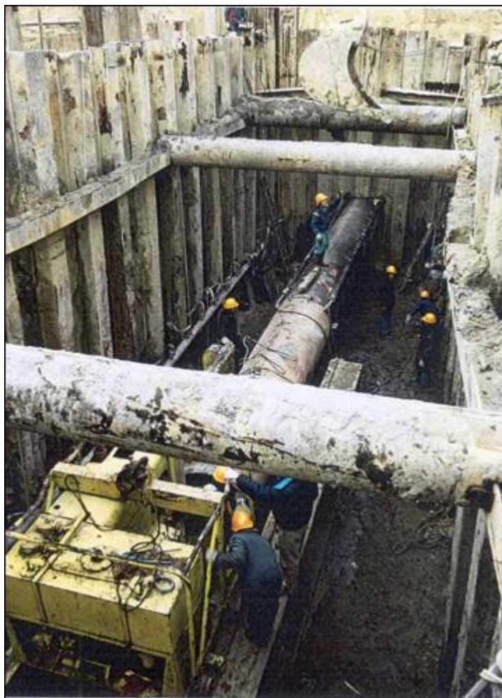
Trivellazione con spingitubo
