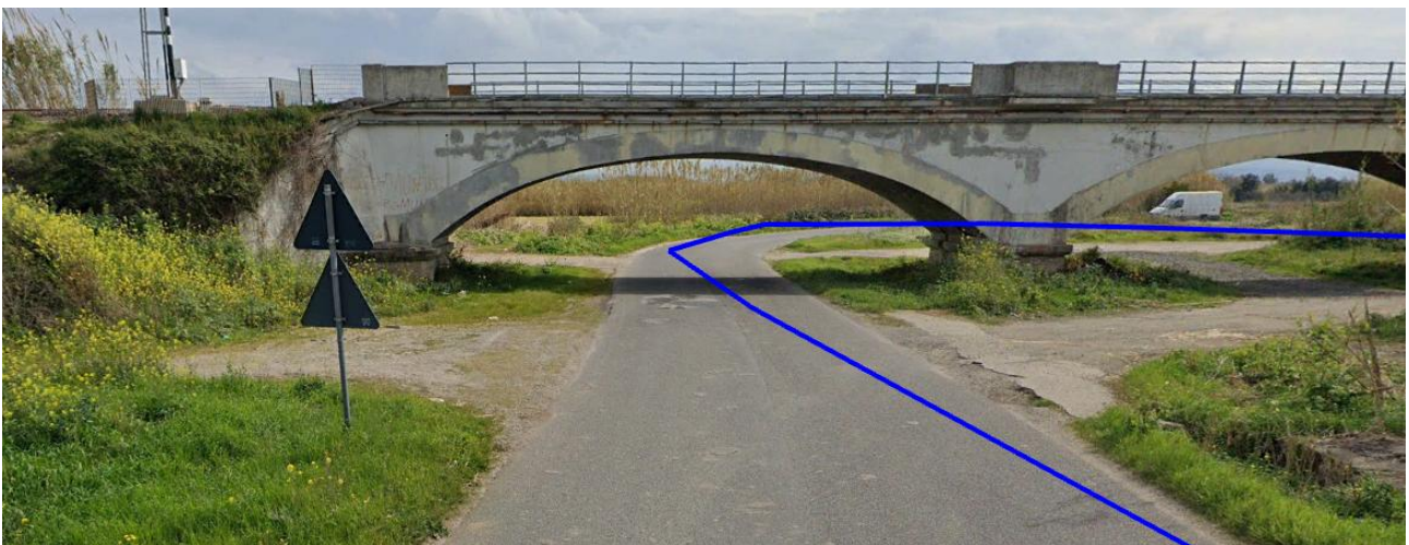
Figura 23: Attraversamento linea di connessione in corrispondenza della rete ferroviaria (fonte: Google Earth).
