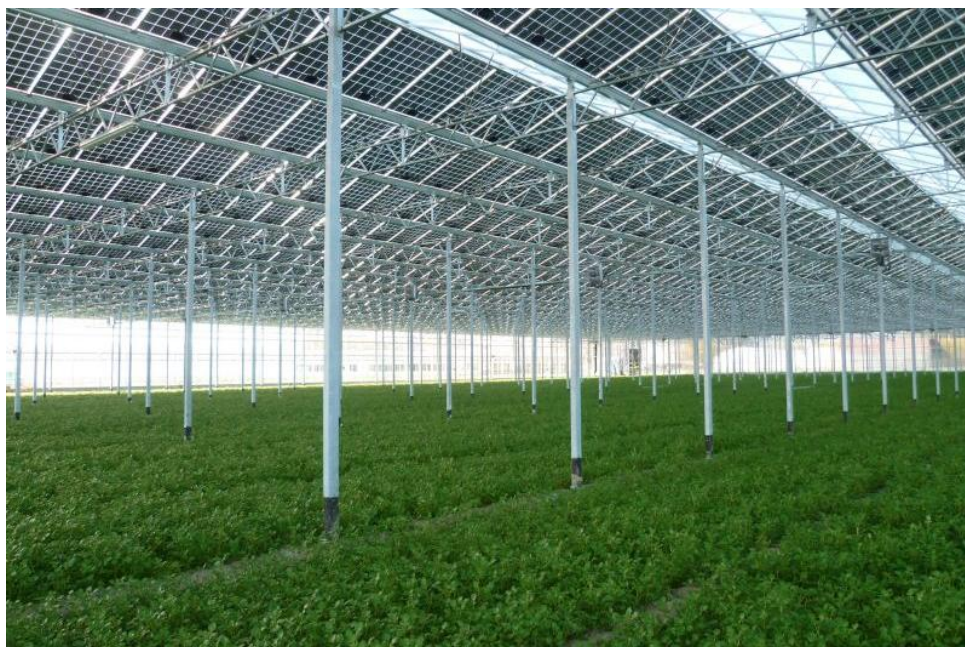
Figura 60: esempio impianto AGV con coltivazioni sottostanti.
