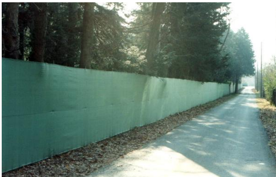
Figura 54: Esempio applicazione di reti antipolvere e frangivista.
